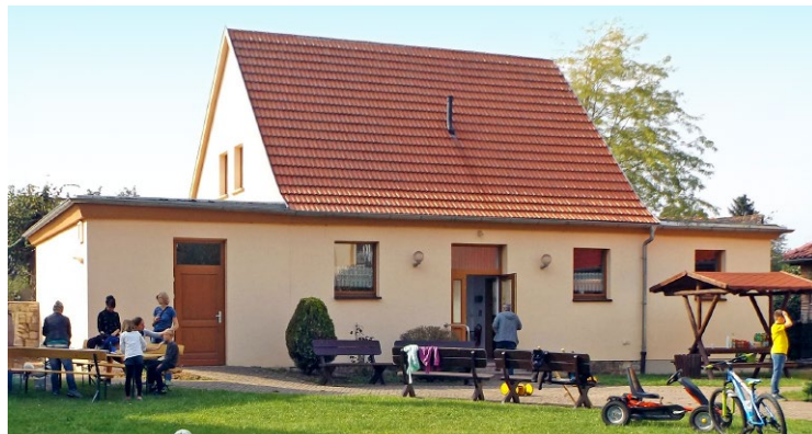
So sieht das Bürgerhaus jetzt aus.
