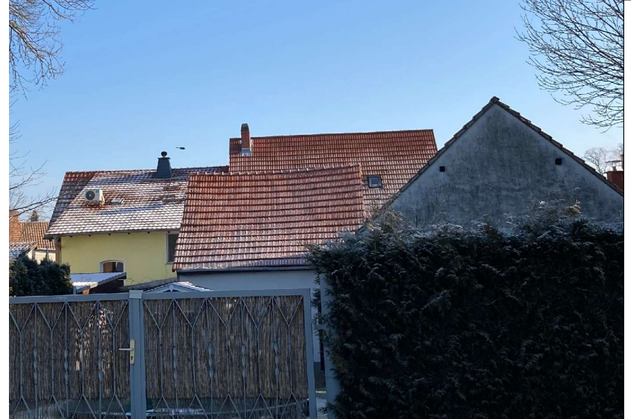
IP5 - Wohnhaus „Hintergasse 37“, A-höhe 2,8 m und 5,8 m
