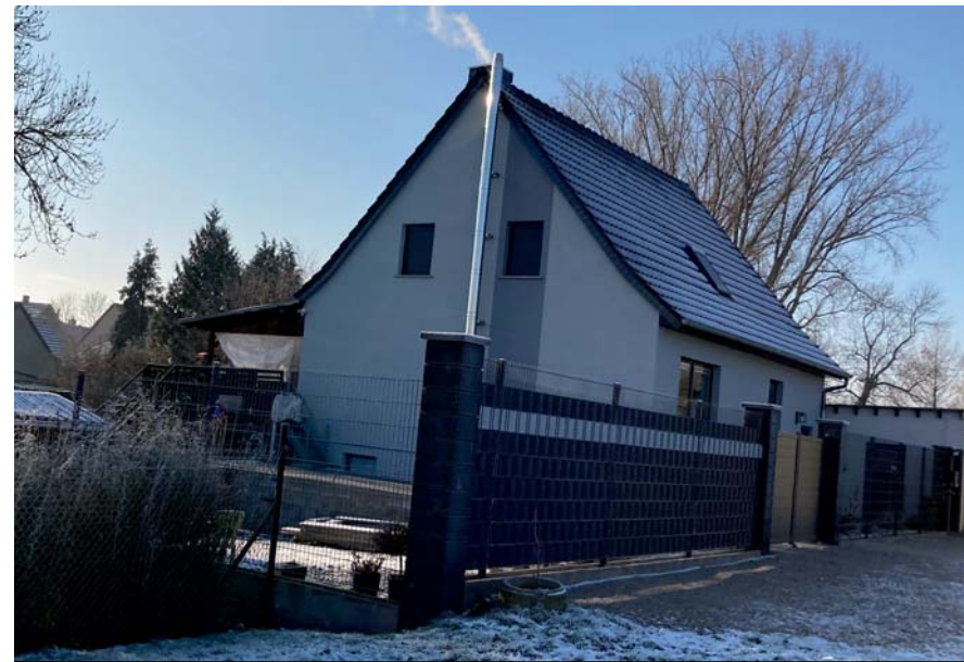
IP1b - Wohnhaus „Hintergasse 43a“, A-höhe 2,8 m und 5,8 m
